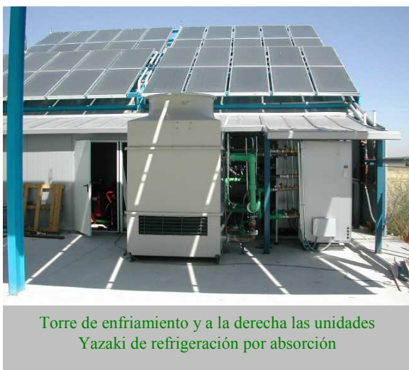
Distribución paneles solares. Al fondo a la izquierda, la torre de enfriamiento y las unidades Yazaki.
