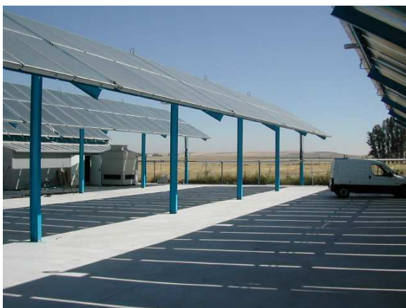
Distribución paneles solares. Al fondo a la izquierda, la torre de enfriamiento y las unidades Yazaki.
